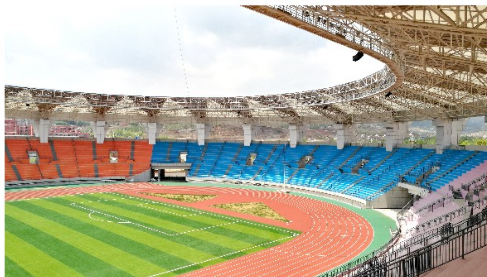
图为云南富源体育馆项目现场（艾索电子线阵音箱扩声应用）
